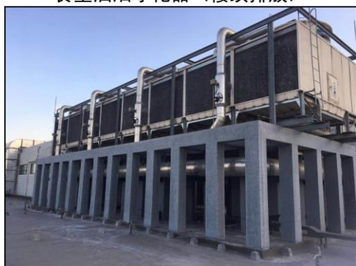
冷却塔（设有消声材料、隔振台等措施）
